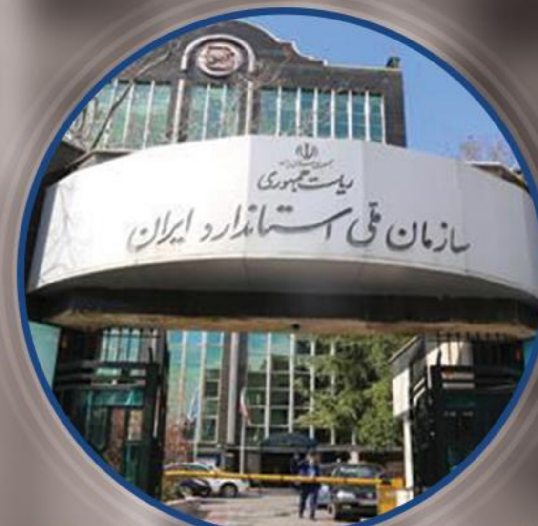
ساختمان شیمی و نساجی س.ا.م.
