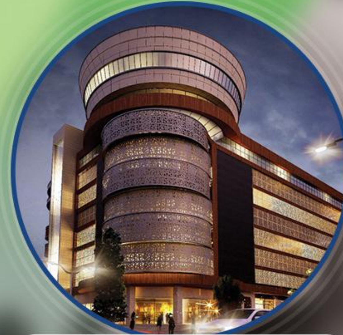
مرکز تجاری قدس شهرک غرب
